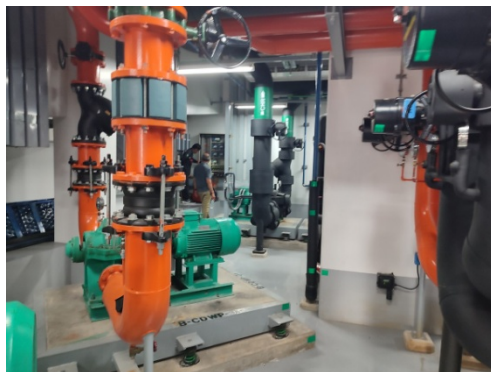
ภาพที่ 4-18 ระบบท่อเย็นของอาคาร และปั๊มสูบน้ำดับเพลิง
