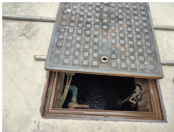
ภาพที่ 4-40 ดูตะกอนที่บ่อเก็บตะกอนของระบบบำบัดน้ำเสีย
