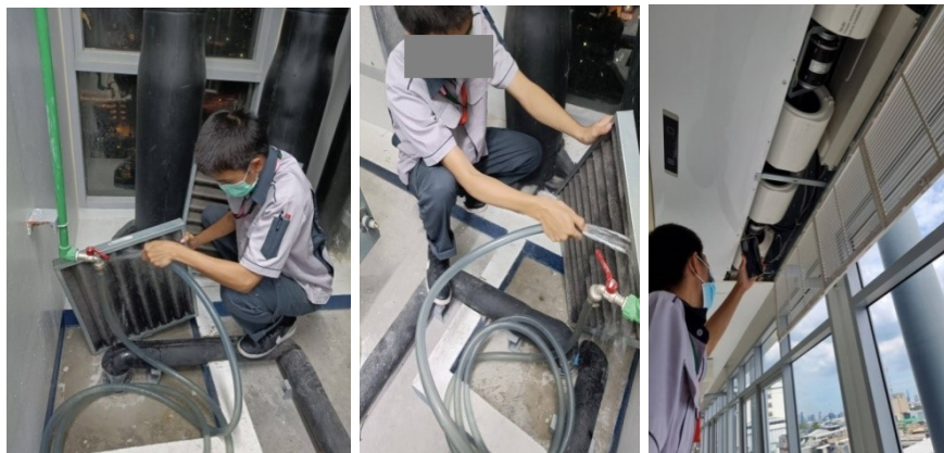
ภาพที่ 4-34 ทำความสะอาดระบบปรับอากาศ
