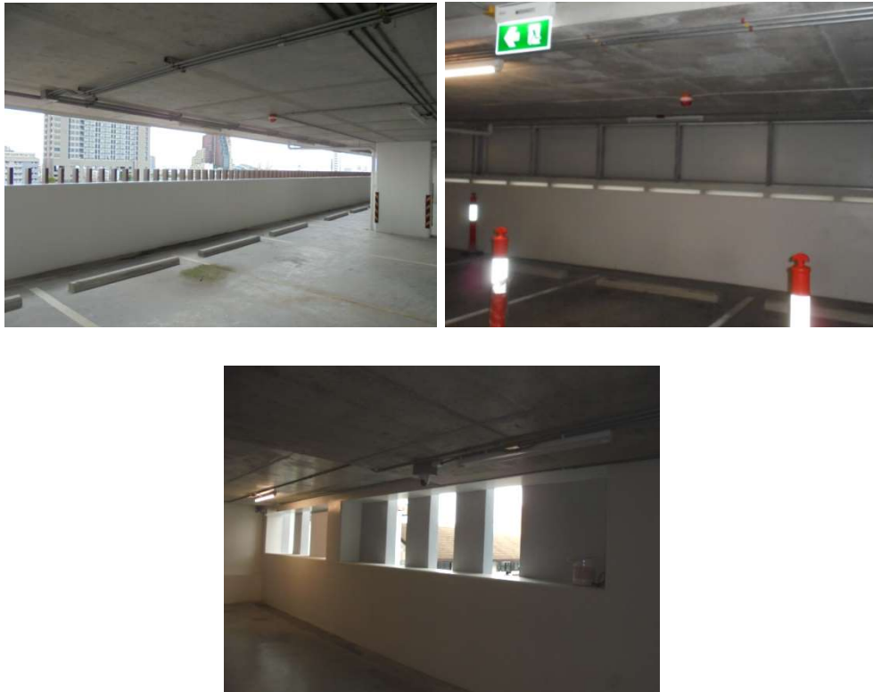
ภาพที่ 4-4 Precast Concrete ชั้นจอดรถชั้น 1-2 Precast Concrete ผนังที่บั้น 3ขึ้นไป
