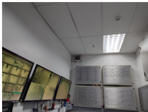
ภาพที่ 4-22 แผงควบคุมการรับส่งสัญญาณอัคคีภัย
